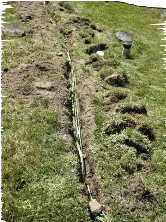
Slang med markeringsnät lägges i gräsmatta
