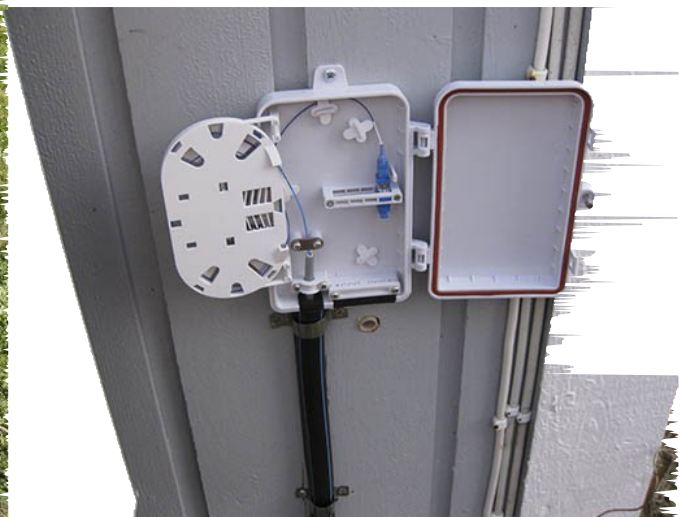
En liten anslutningsbox monteras
